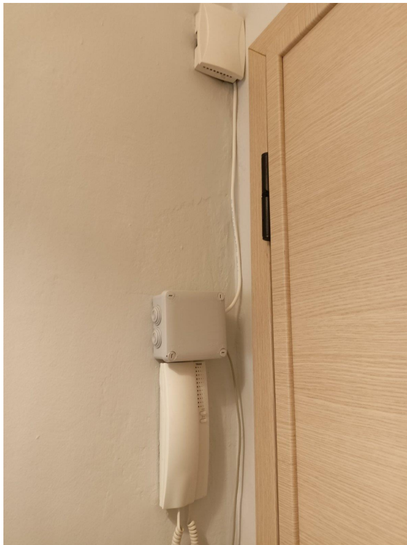
Εικόνα 4.7: Σύνδεση ανιχνευτή με κουδούνι θύρας
