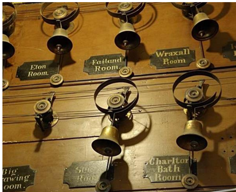
Εικόνα 1-1: Σύστημα κλήσης με τροχαλία.
