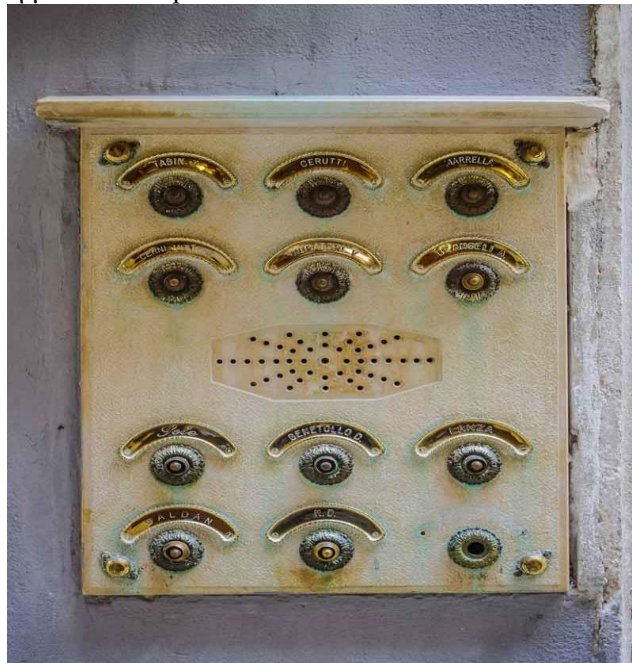
Εικόνα 1-4 Εξωτερικό πάνελ σε πολυκατοικία στην δεκαετία του 1950.
