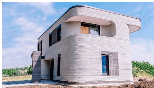
Εικόνα 1.3. Το πρώτο 3D εκτυπωμένο σπίτι στην Γερμανία
