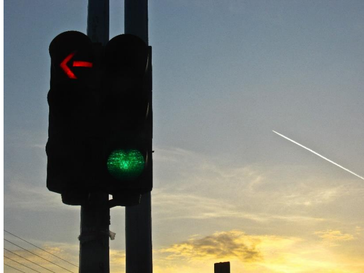
Εικόνα 1.9 : Συνεγκατάσταση δύο φαναριών στον ίδιο στύλο
