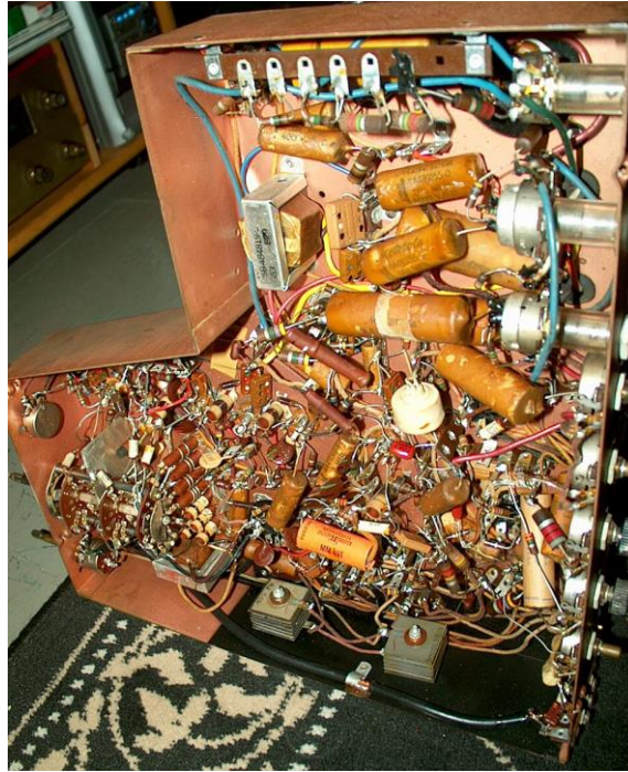
Εικόνα 2-1 Ευκολά προσβάσιμο κύκλωμα με καλωδιώσεις σημείου με σημείου [32]
