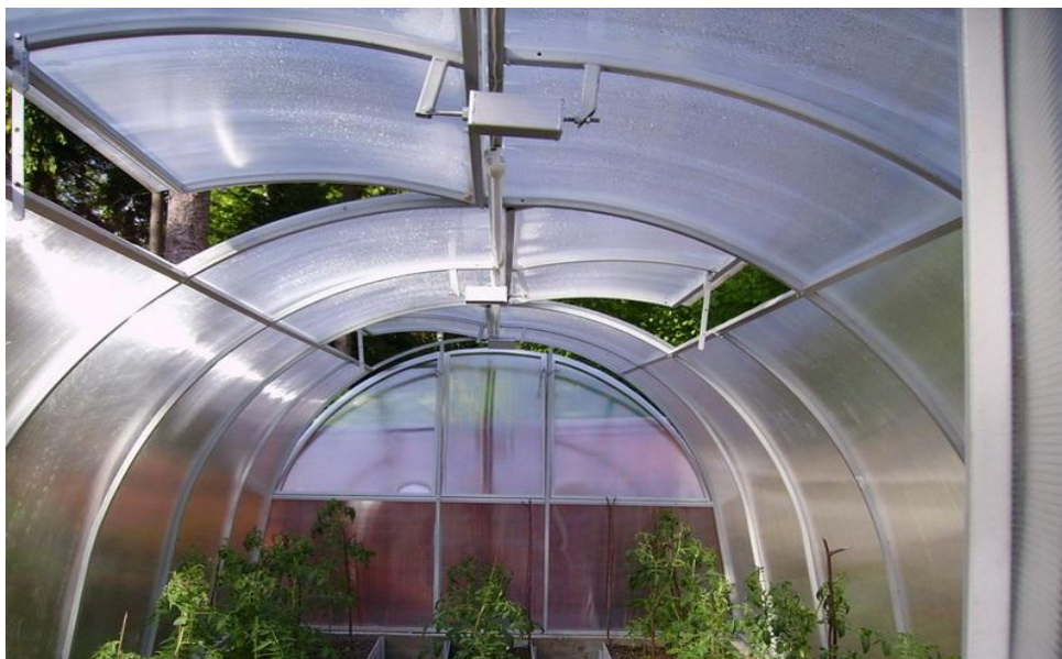
Εικόνα 12. Σύστημα εξαερισμού με παράθυρα στην οροφή
