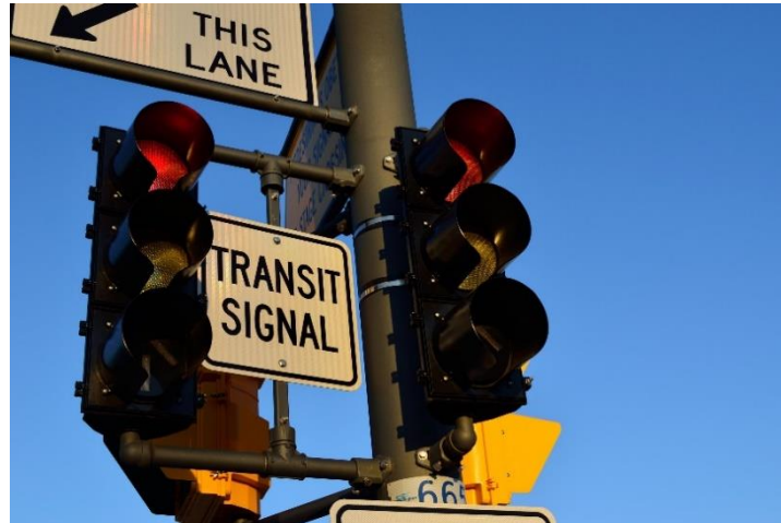
Εικόνα 1.11. Στερέωση πάνω σε οριζόντιο άξονα με διπλούς βραχίονες.
