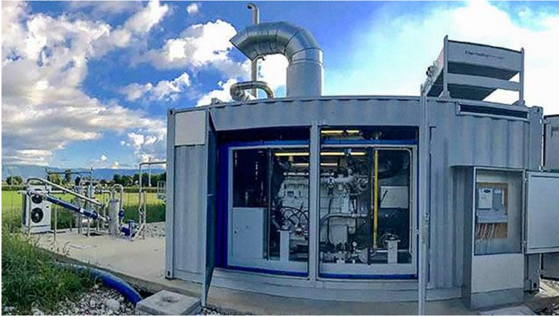
Σχήμα 2.6. Σύστημα Micro-CHP με προσαρμοσμένο έναν κινητήρα εσωτερικής καύσης για βιομηχανική εφαρμογή μικρής κλίμακας.
