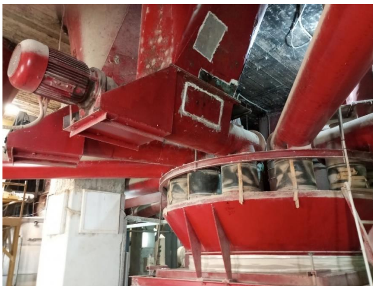
Εικόνα 4.10: Οδήγηση πρώτων υλών και premix στην ζυγαριά.
