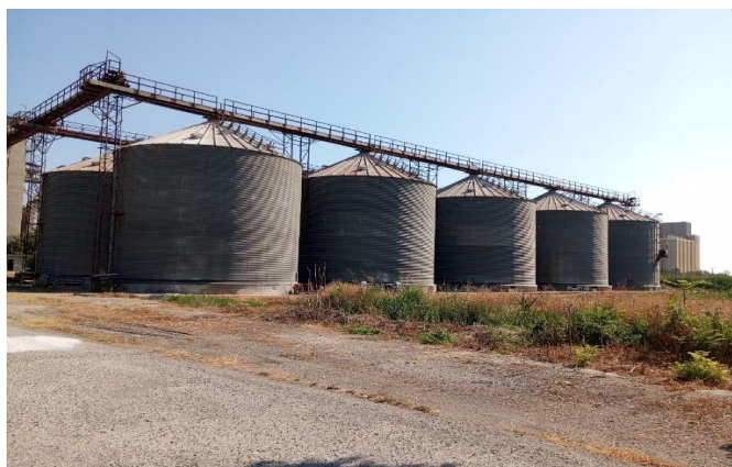
Εικόνα 4.3: Μεταλλικά σιλό αποθήκευσης σιτηρών 1000 τόνων.
