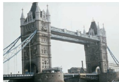
Εικόνα 31.6: Η γέφυρα του Πύργου του Λονδίνου
