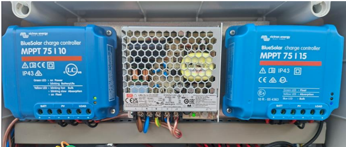
Σχήμα 4-13: Ρυθμιστές φόρτισης MPPT των δύο φωτοβολταϊκών συστημάτων
