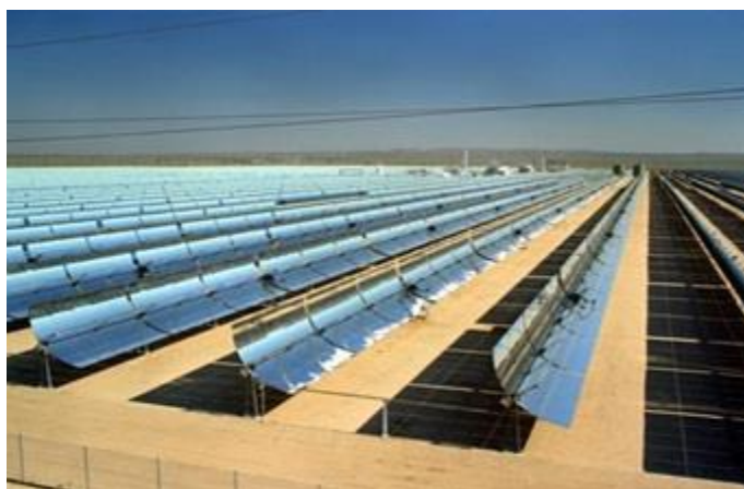
Σχήμα 3.11: Συγκεντρωτικοί Συλλέκτες Ηλιακής Ακτινοβολίας
