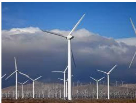
Σχήμα 1.11: Ανεμογεννήτρια Οριζόντιου Άξονα
