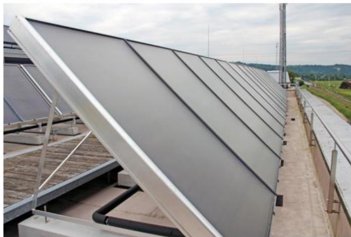
Σχήμα 5.1 : Επίπεδος συλλέκτης PowerSol 55
