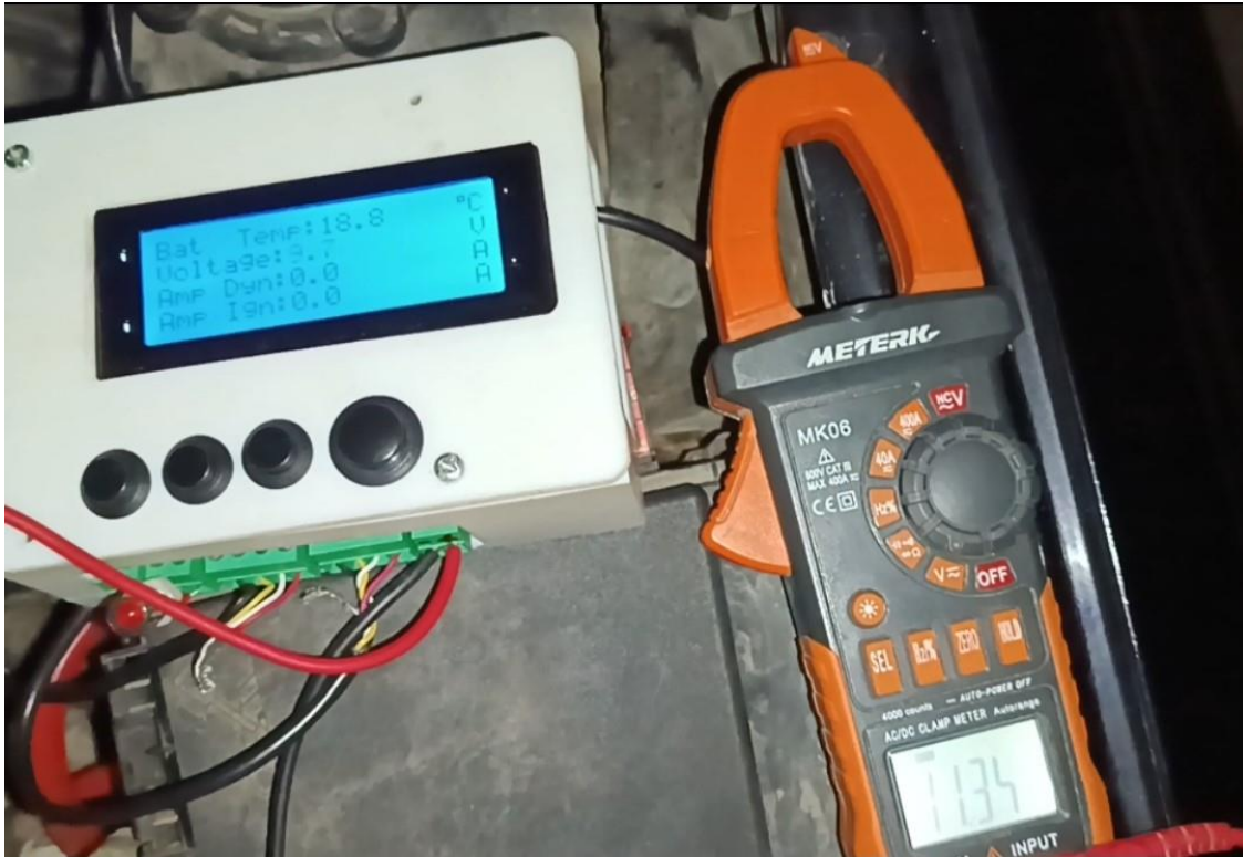
Εικόνα 44: Μέτρηση μπαταρίας κατά την εκκίνηση με τον αισθητήρα
