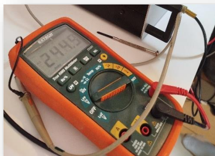
Σχήμα 5.13: Μέτρηση τάσης δικτύου με πολύμετρο
