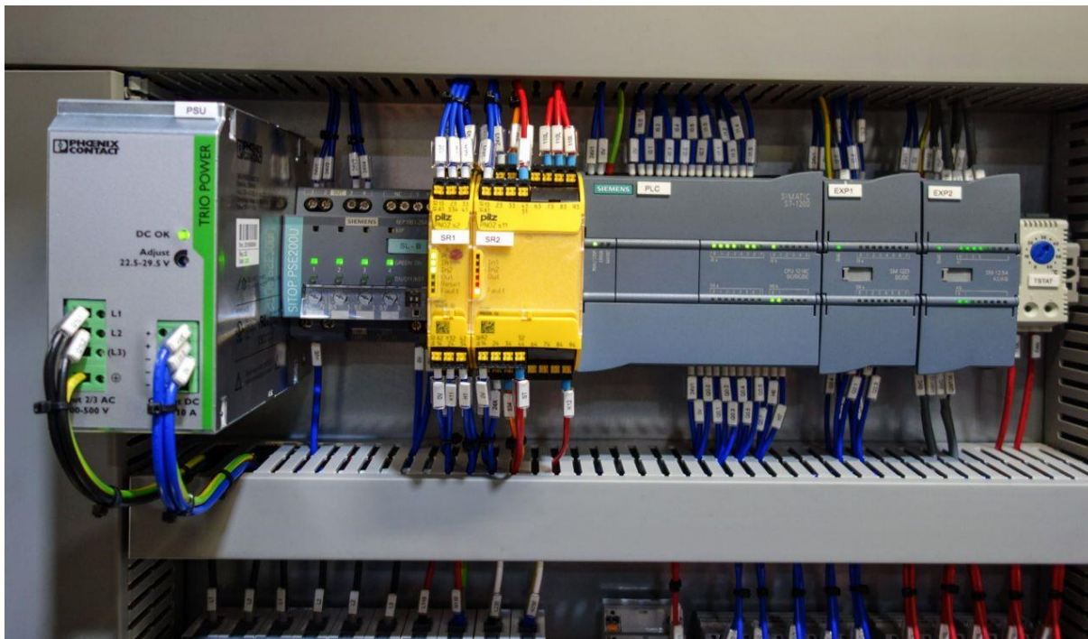
Εικόνα 2-1: Στην βιομηχανία συνηθίζεται μία συστοιχία PLC να ελέγχεται από ένα άλλο PLC [20].
