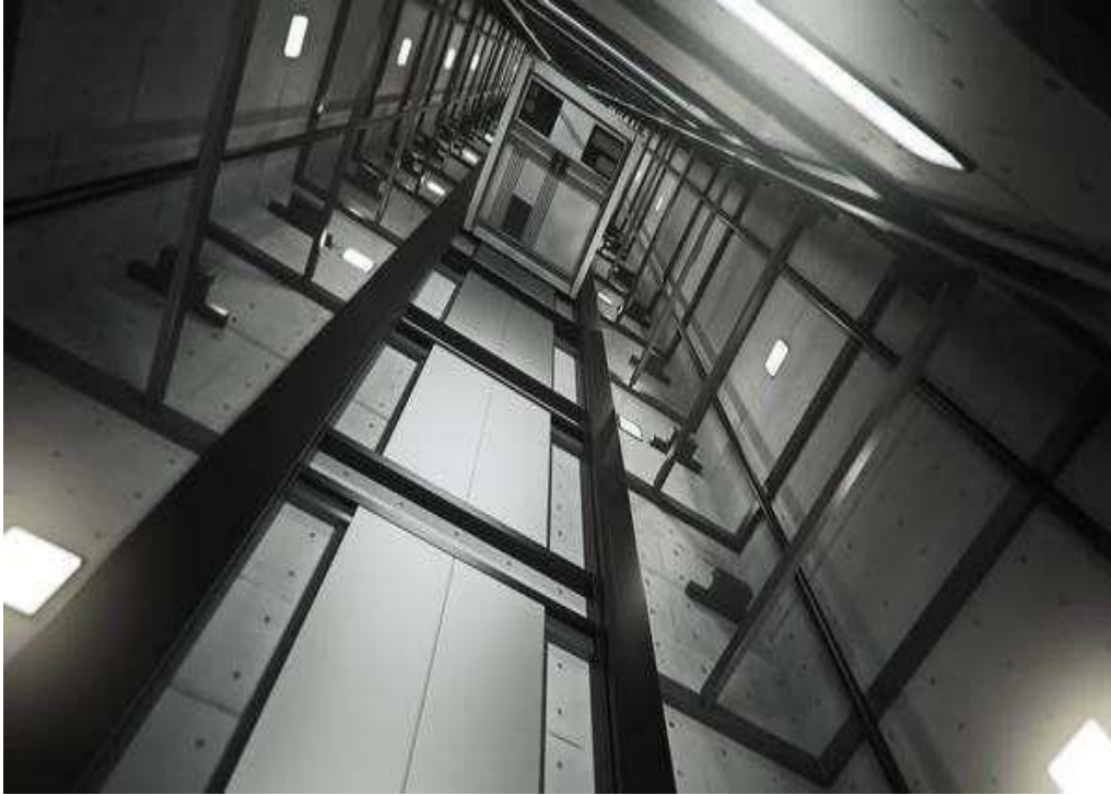
Σχήμα 1.3 Φρεάτιο ηλεκτροκίνητου ανελκυστήρα έλξεως
