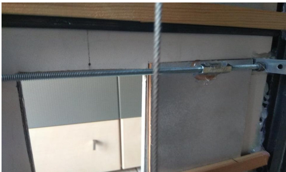
Σχήμα 4.7 Πόρτα στερεωμένη σε βίδα
