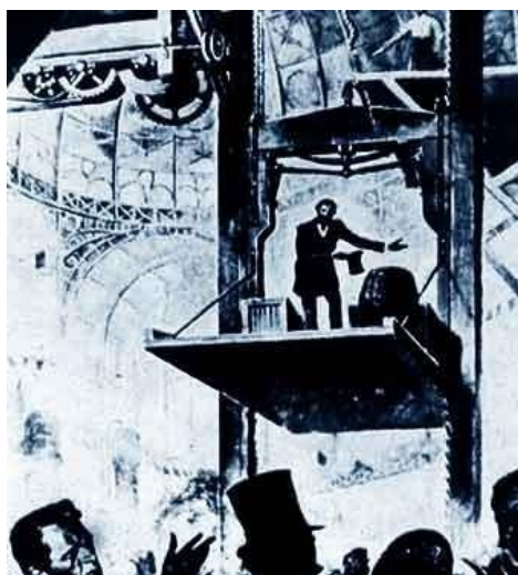
Σχήμα 1.2 Ανυψωτικός μηχανισμός της Otis
