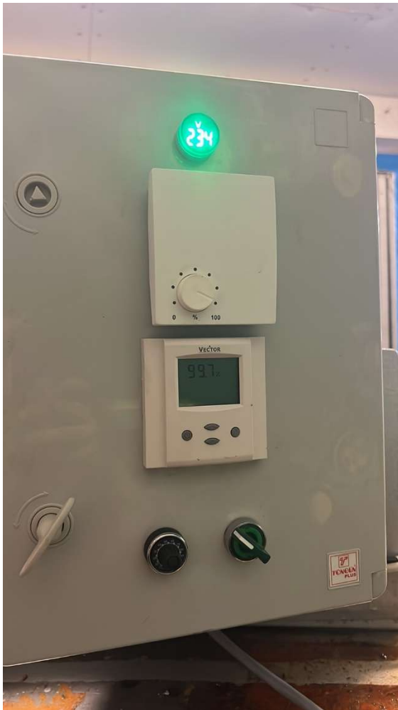
Εικόνα 4.2. Πίνακας διαχείρισης κυκλώματος και βάνας παροχής της τουρμπίνας.
