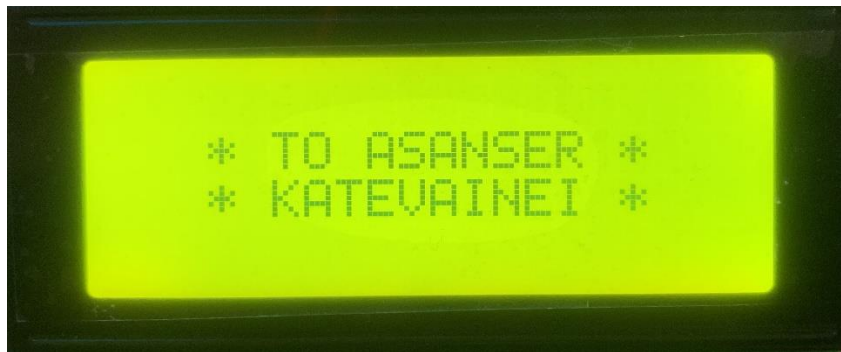
Εικόνα 30. Οθόνη για την κατάσταση του θαλάμου
