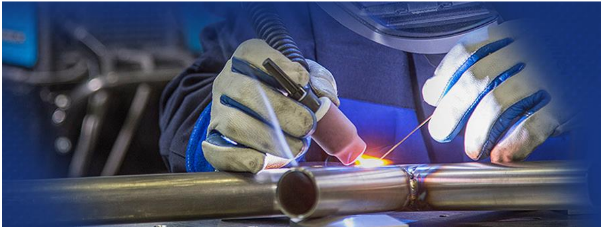
Εικόνα 1.12: Εκτέλεση ηλεκτροσυγκόλλησης TIG
