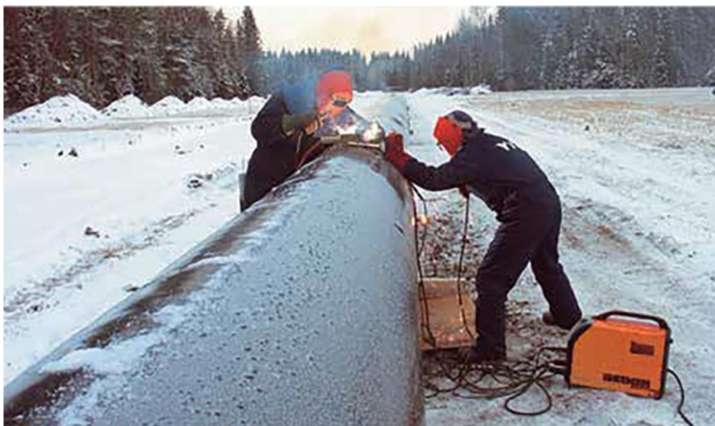
Εικόνα 1.17: Ηλεκτροσυγκόλληση MMA σε αγωγό φυσικού αερίου στη Σιβηρία
