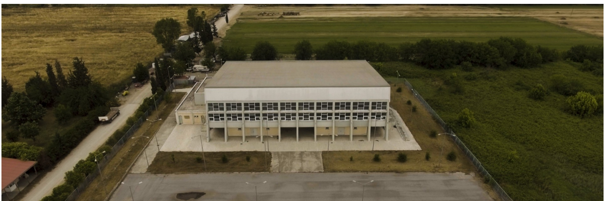
Εικόνα 26: Εναέρια Φωτογράφιση Κλειστού Γυμναστηρίου ΔΠΠΑΕ, Σίνδος
