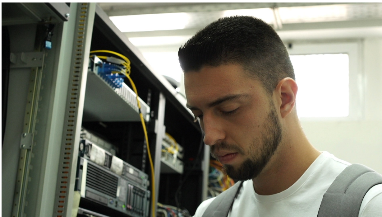
Εικόνα 33: Λήψη στο χώρο του κέντρου δικτύων, λήψη 2
