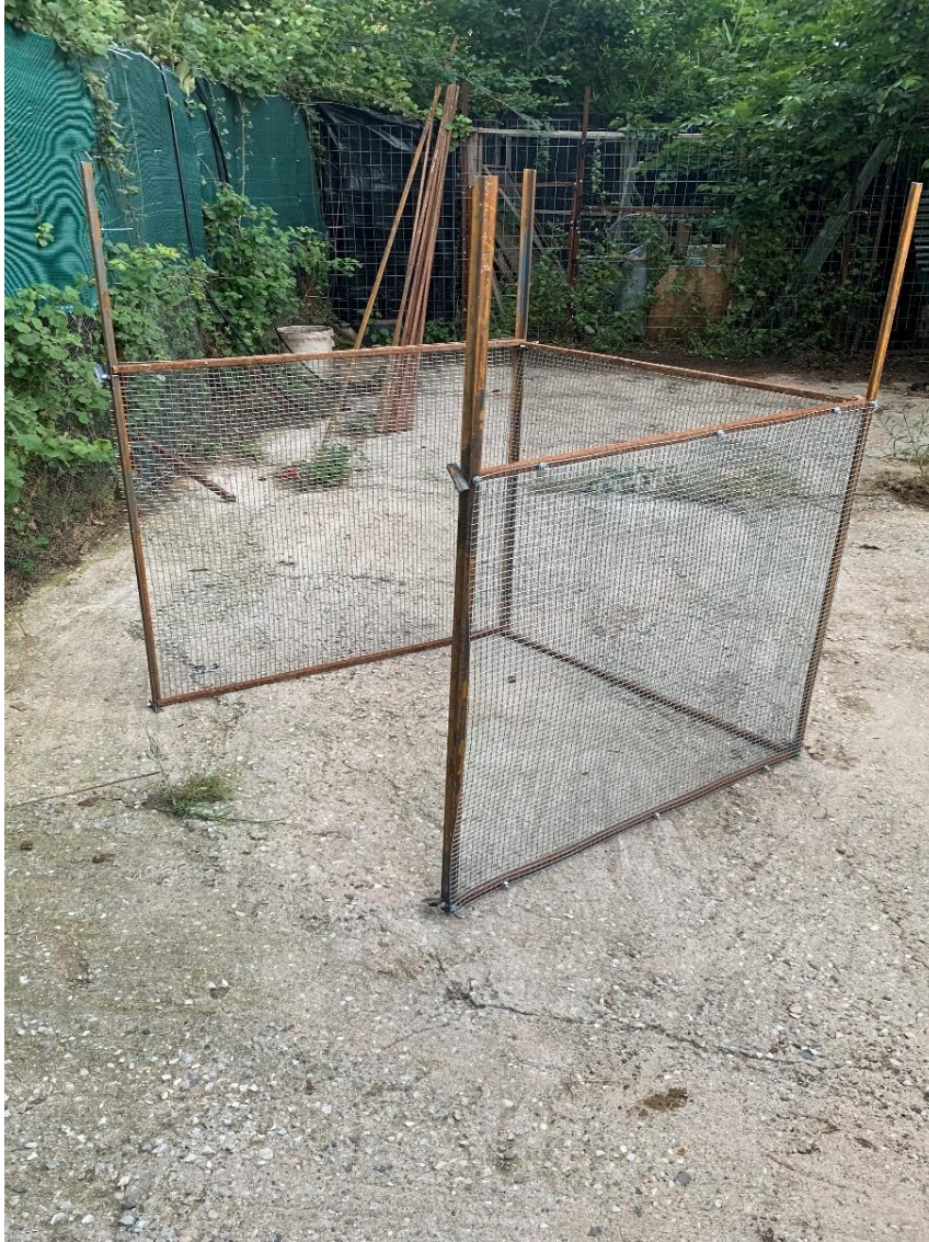
Εικόνα 84: Σύνδεση Των Επιμέρους Πλαίσιων
