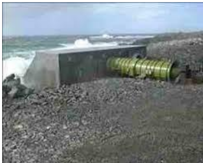
Σχήμα 1.19: Σύστημα ταλαντευόμενης στήλης
