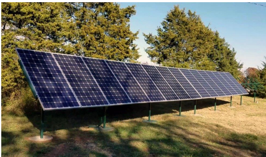
Σχήμα 2.7: Μερική σκίαση φωτοβολταϊκών πλαισίων
