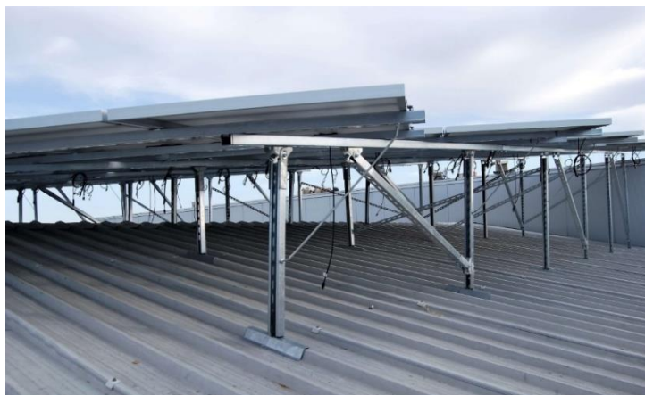
Σχήμα 2.15: Βάσεις τοποθέτησης φωτοβολταϊκών πλαισίων σε μεταλλική στέγη
