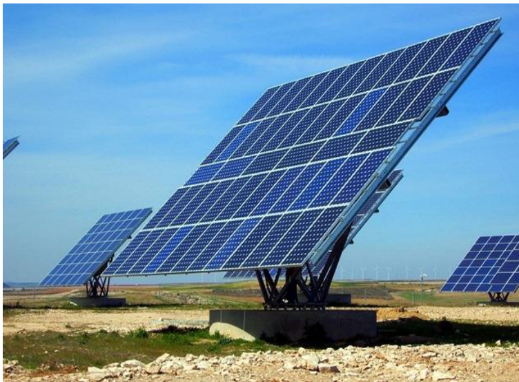
Σχήμα 2.17 : Κινητές βάσεις στηρίξεις ιχνηλάτες
