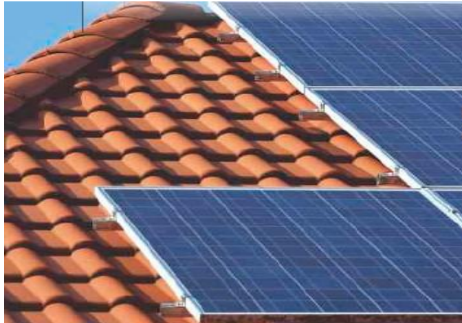
Σχήμα 2.16 : Σταθερές βάσεις στηρίξεις σε κεραμιδιά
