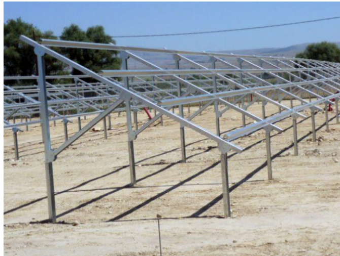
Σχήμα 2.12: Βάση στήριξης διπλής στερέωσης
