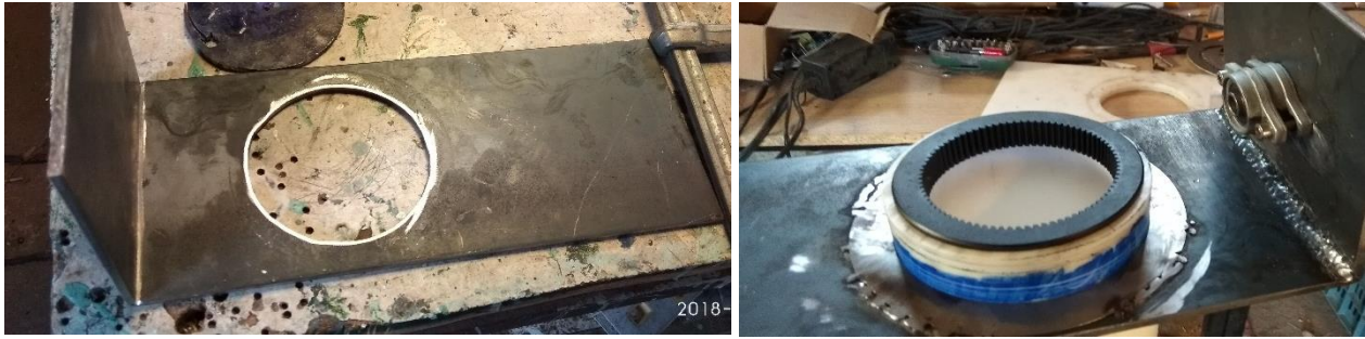
Σχ. 5.13 Η κατασκευή της βάσης από λαμαρίνα
