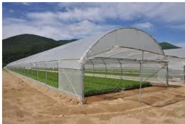
Εικόνα 9: Απλό τροποποιημένο τοξωτό θερμοκήπιο
