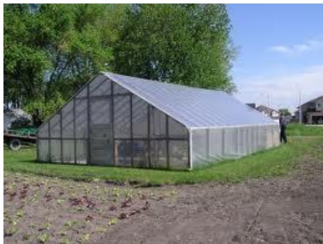
Εικόνα 5: Απλό Αμφίρρικτο θερμοκήπιο
