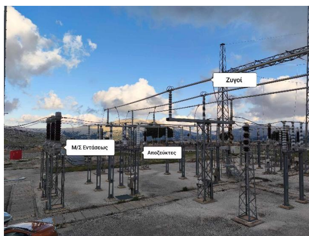
Σχήμα 3.1 Μ/Σ εντάσεως και λοιπά συστήματα
