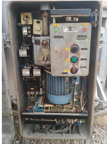
Σχήμα 1.23 Αυτόματη μεταγωγή (OLTC)
