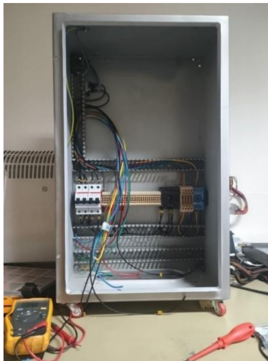
Σχήμα 6.5 Τοποθέτηση υλικών ράγας RO, RC, RCT και Δικακοπτών B6 S202
