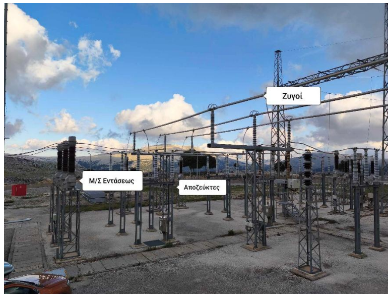
Σχήμα 1.8 Ζυγοί υψηλής τάσης
