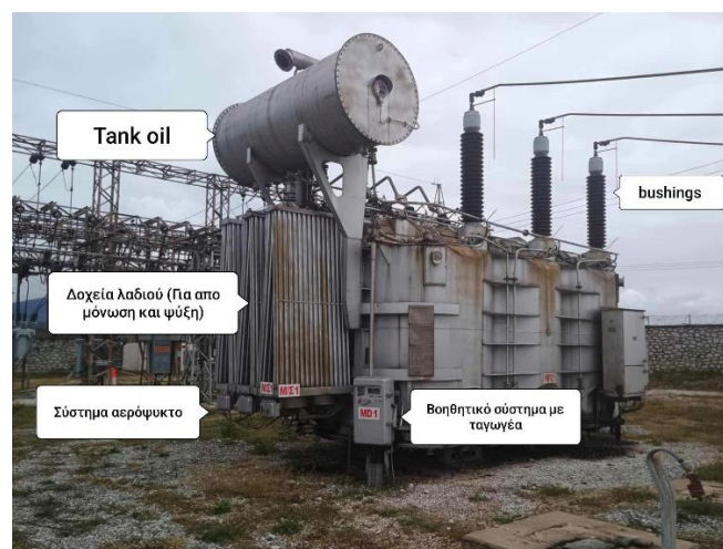
Σχήμα 4.1 Μετασχηματιστής Ισχύος
