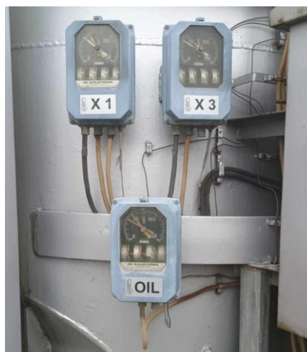
Σχήμα 1.5 Θερμόμετρα Μ/Σ ισχύος
