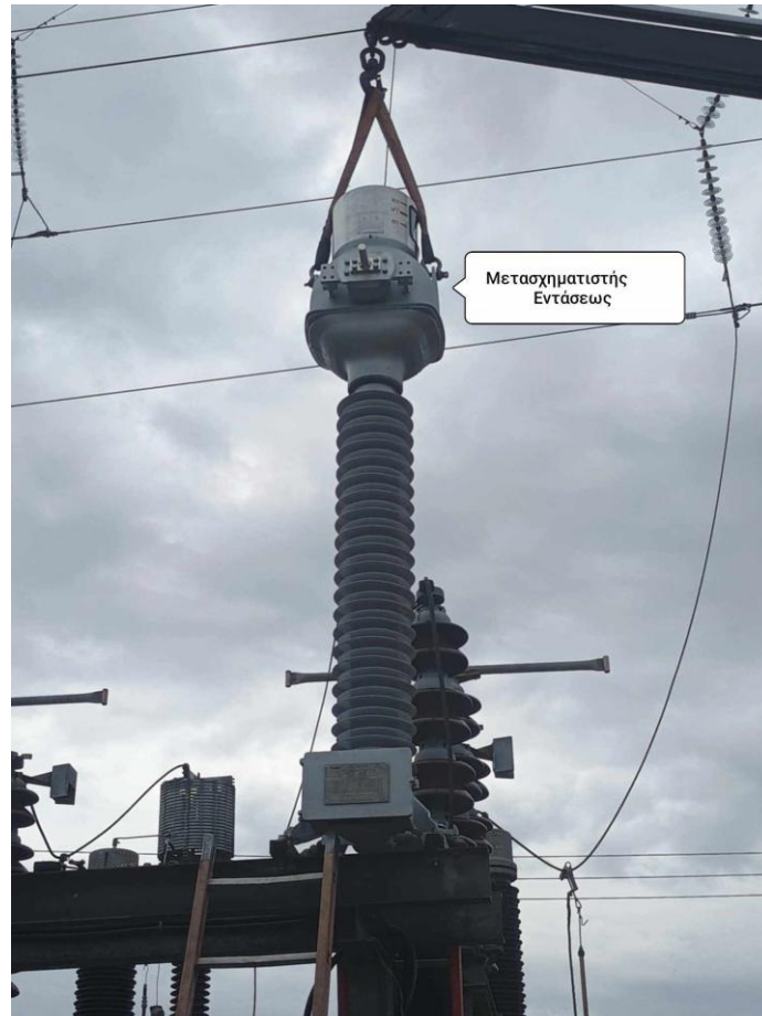
Σχήμα 3.5 Μετασχηματιστές Εντάσεως
