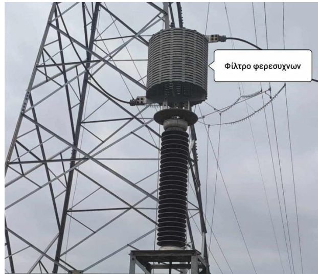
Σχήμα 1.19 Φίλτρο φερέσυχων
