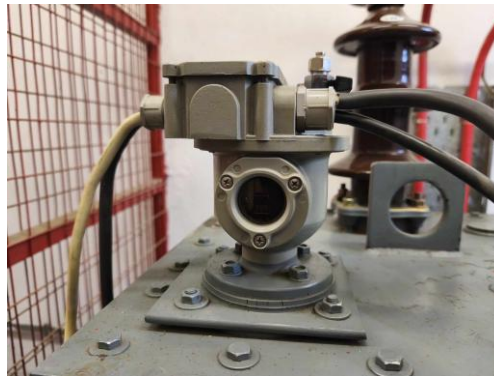
Σχήμα 1.14 Σύστημα Buchholz
