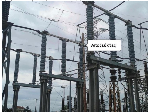
Σχήμα 1.7 Αποζεύκτης (μαχαιρωτοί διακόπτες)
