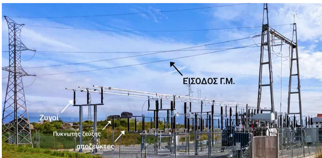
Σχήμα 1.1 Γραμμές εισόδου (Τάση εισόδου 150kV)
