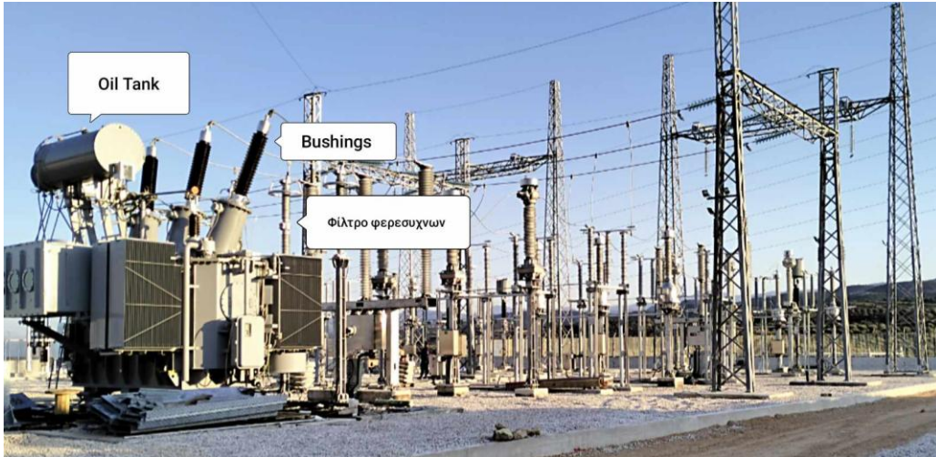
Σχήμα 1.2 Μετασχηματιστής Ισχύος
