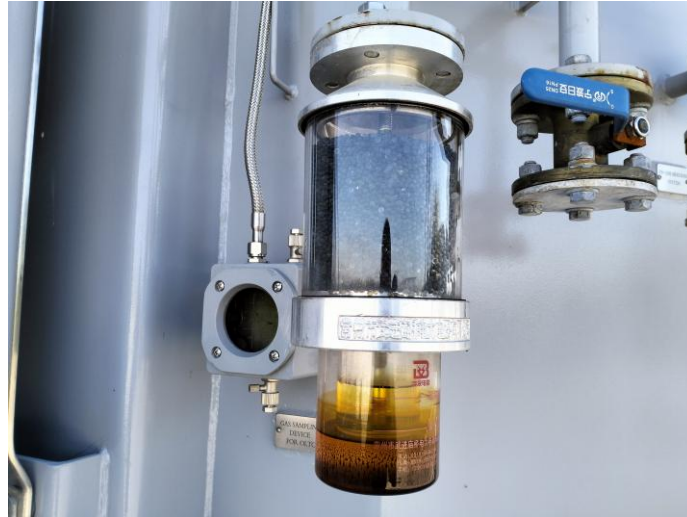
Σχήμα 4.4 Απομόνωση υγρασίας Silica gel
