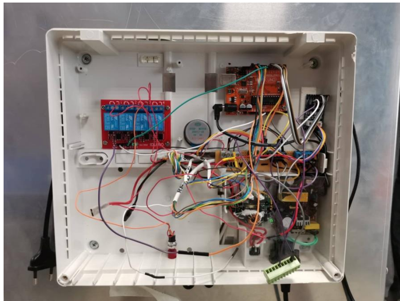
Εικόνα 4. 18 Τοποθέτηση και συνδεσμολογία εξαρτημάτων
