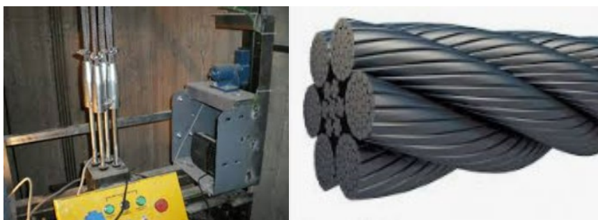
Εικόνα 2.12 Συρματόσχοινα ανάρτησης
