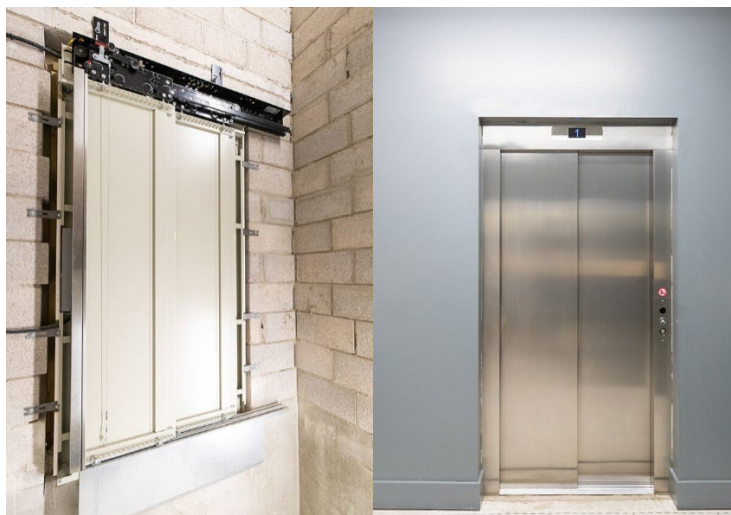
Εικόνα 2.8 Πόρτες ανελκυστήρα (εσωτερικά – εξωτερικά)
