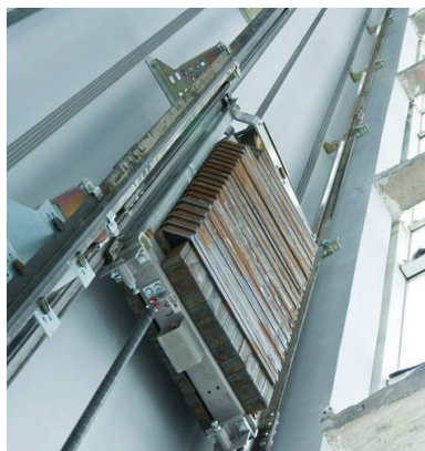
Εικόνα 2.11 Αντίβαρο ανελκυστήρα
