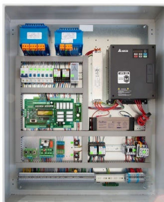
Εικόνα 2.4 Σύγχρονος πίνακας ελέγχου για ηλεκτροκίνητους ανελκυστήρες έλξεως με inverter
