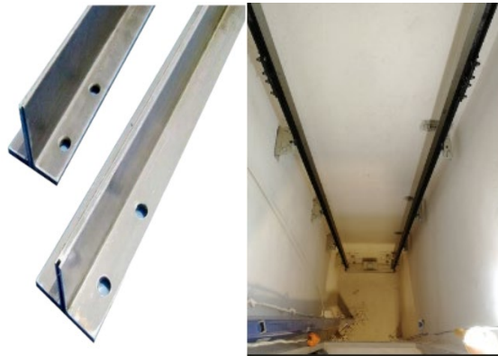
Εικόνα 2.10 Οδηγοί ανελκυστήρα
