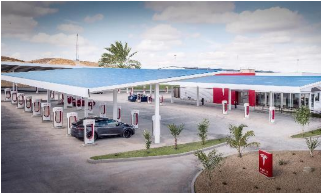
Σχήμα 1.2 Σταθμός φόρτισης ηλεκτρικών οχημάτων της Tesla με παραγωγή της απαιτούμενης για τη φόρτιση ηλεκτρικής ενέργειας μέσω φωτοβολταϊκών.
