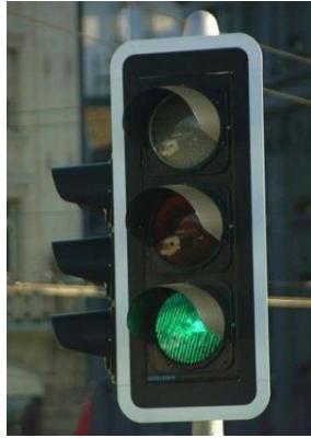
Εικόνα 1.13: Φωτεινός σηματοδότης όπου διακρίνεται το λευκό πλαίσιο αντίθεσης
