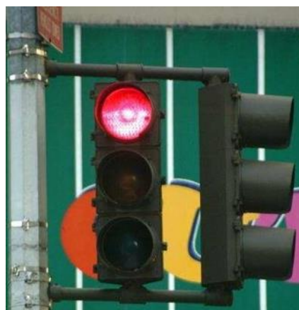
Εικόνα 1.12: Στερέωση με βραχίονα με επέκταση
