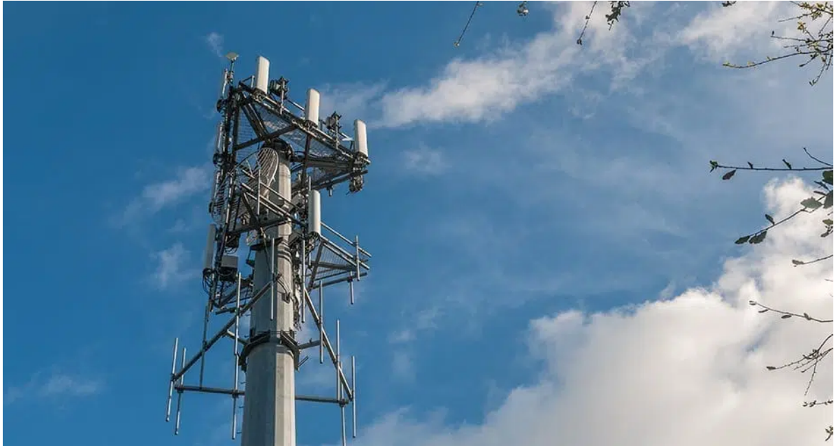
Σχήμα 1.12: Μια 4G 4x4 κεραία MIMO [38].
