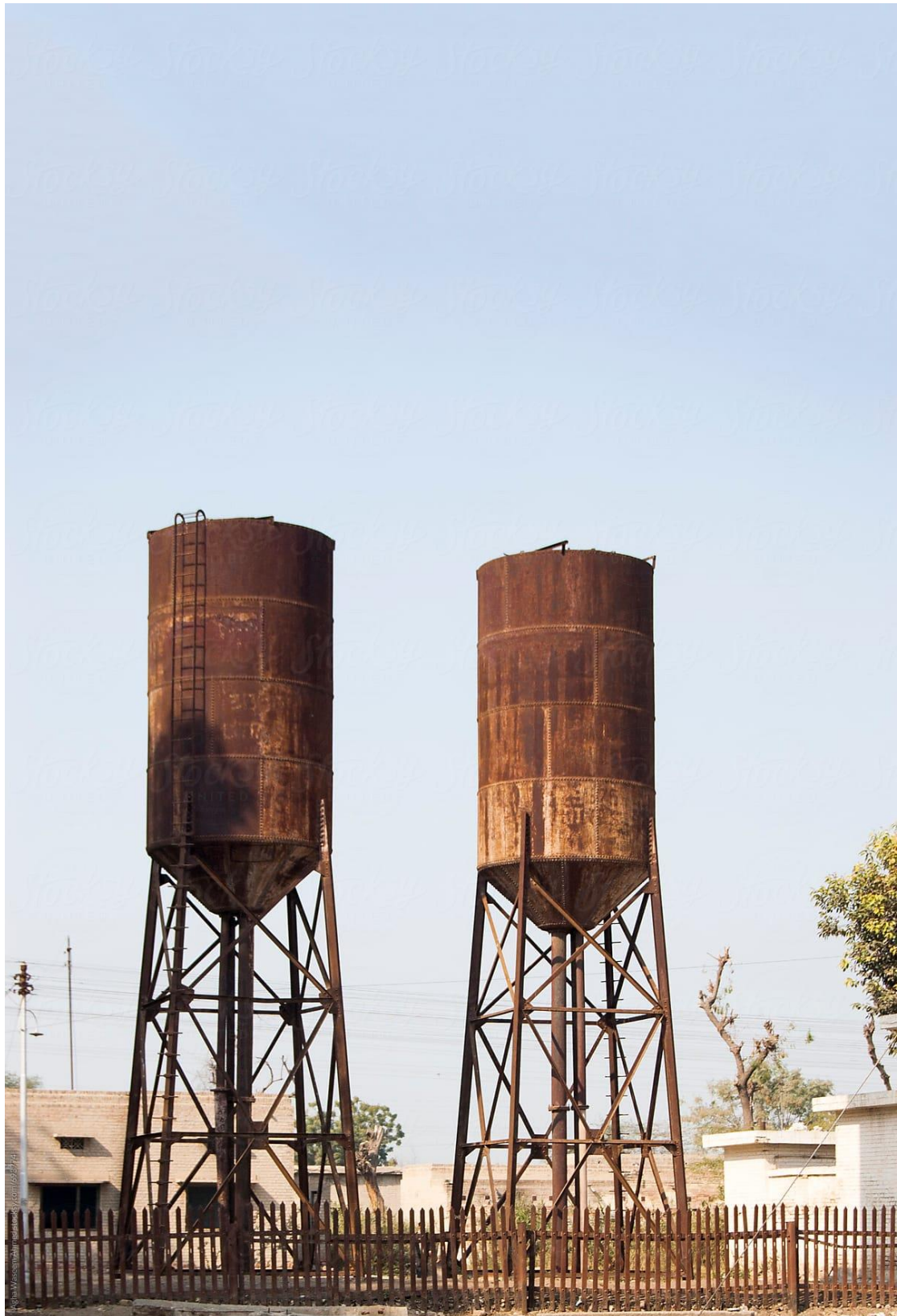
Εικόνα 3. Παλιές Δεξαμενές Ύδρευσης.
