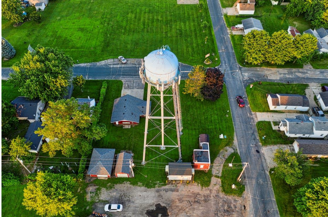
Εικόνα 2. Δεξαμενή ύδρευσης με πόσιμο νερό στην Αμερική.
