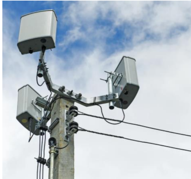
Εικόνα 4: Smallcells σε κολώνα [40]
