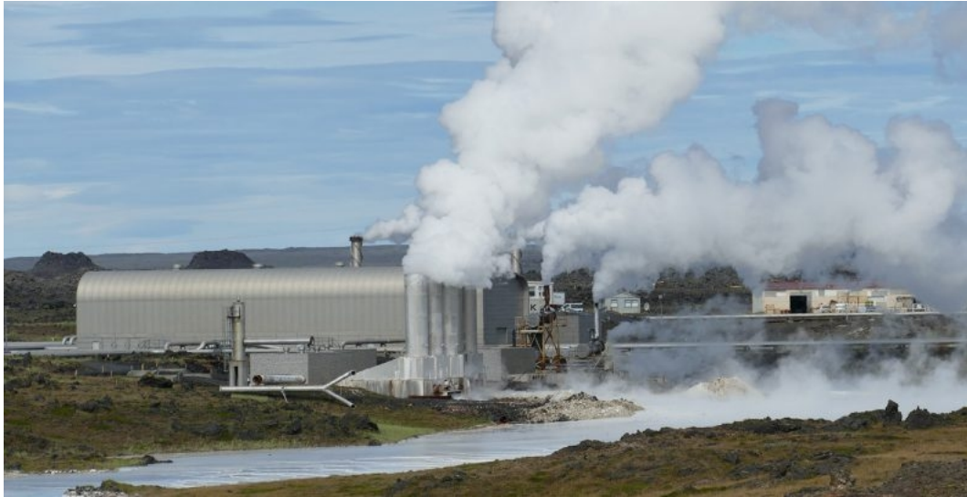
Σχήμα 1.7: Μονάδα γεωθερμικής παραγωγής ηλεκτρικής ενέργειας [8].
