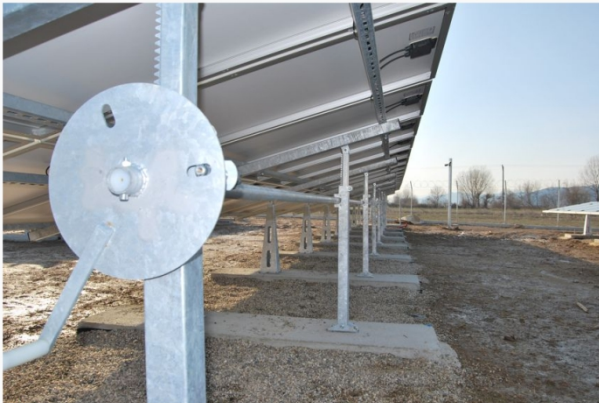
Σχήμα 2.12: Μονοαξονική διάταξη ιχνηλάτησης με χειροκίνητη προσαρμογή [46]
