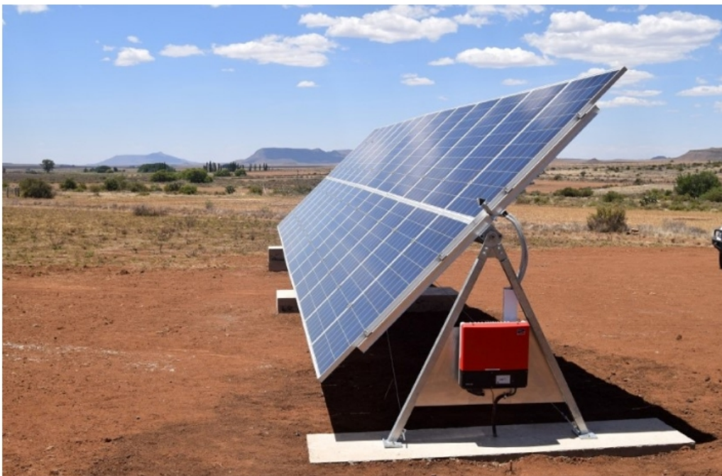
Σχήμα 2.10: Μονοαξονικές διατάξεις ιχνηλάτησης της πορείας του ήλιου.[45]
