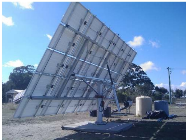
Σχήμα 2.11: Διαξονικές διατάξεις ιχνηλάτησης της πορείας του ήλιου.[44]
