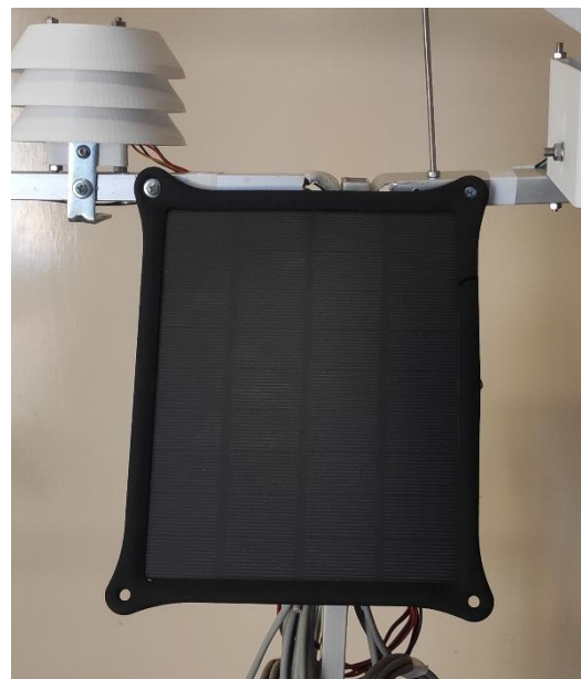
Εικόνα 4.36: Τοποθέτηση PV πάνελ στην κατασκευή με φορά προς Νότο
