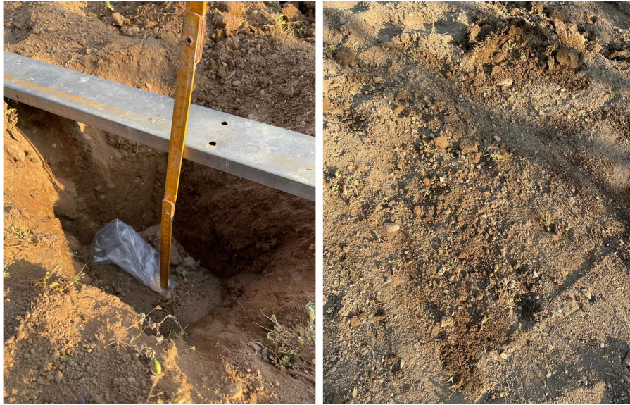
Εικόνα 27: Μέτρηση του βάθους ταφής και μετά την ταφή
