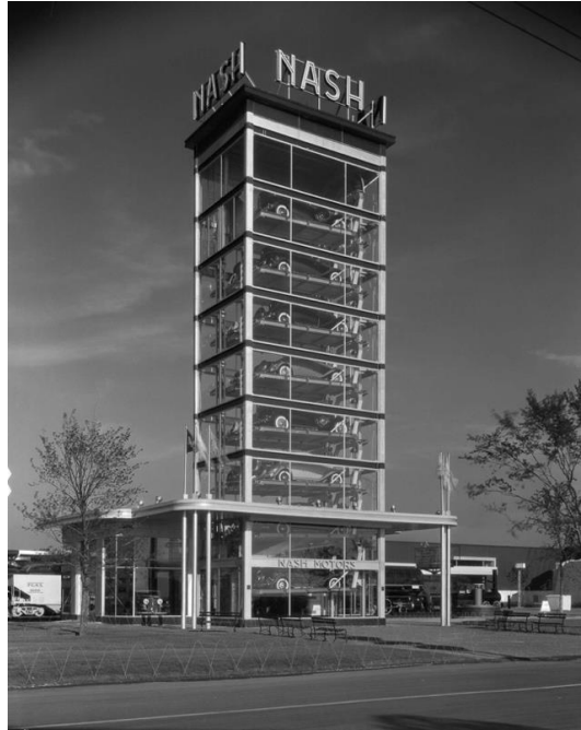
Εικόνα 1.8: Η Nash Motor Company κατασκεύασε το πρώτο σύστημα πάρκινγκ από γυαλί για την παγκόσμια έκθεση Century of Progress το 1933)
