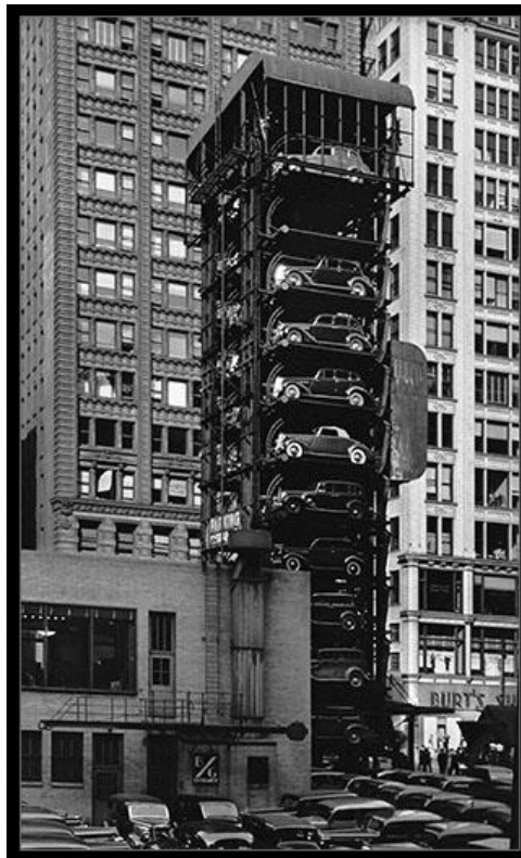
Εικόνα 1.7: Σύστημα στάθμευσης 48 αυτοκινήτων στο κέντρο του Σικάγο (Westinghouse Electric and Manufacturing Company, 1936)
