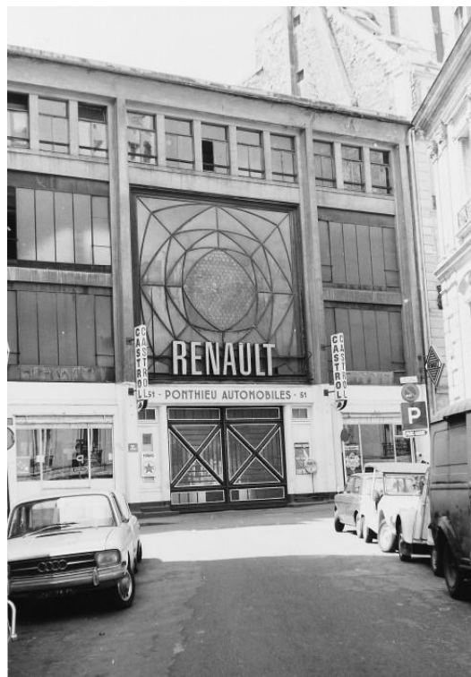
Εικόνα 1.6: Το γκαράζ στην Rue de Ponthieu (κατεδαφίστηκε)
