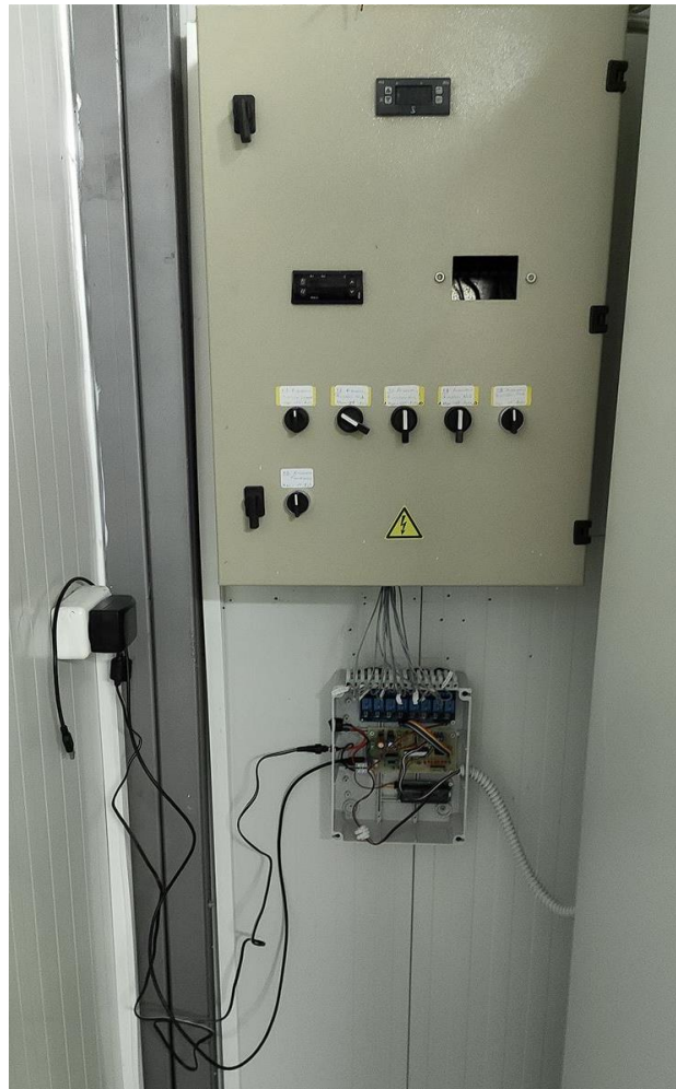
Εικόνα 4.14: Τοποθέτηση κουτιού με τις πλακέτες MCU και ρελέ στον θάλαμο.
